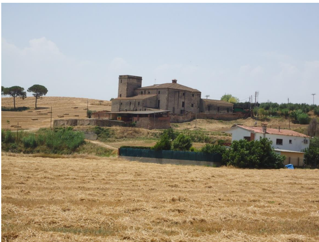
Vistes de la masia catalogada de la Torre de Malla
