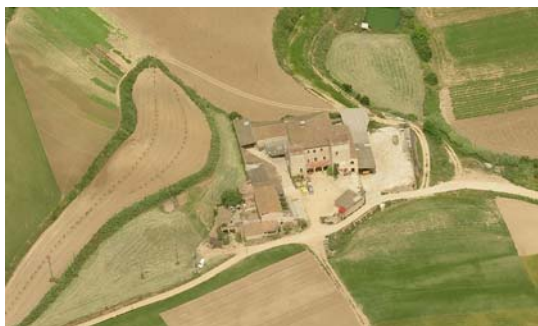
E9. Masia de la Torre d'en Malla (BCIL). Parets del Vallès
