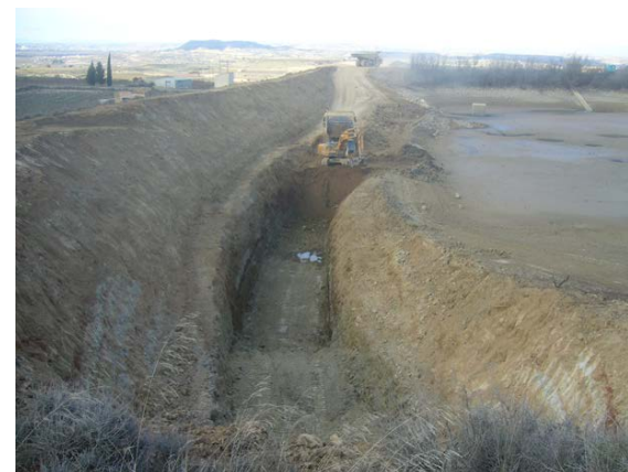
Obres d'emergència, sanejament del dic
