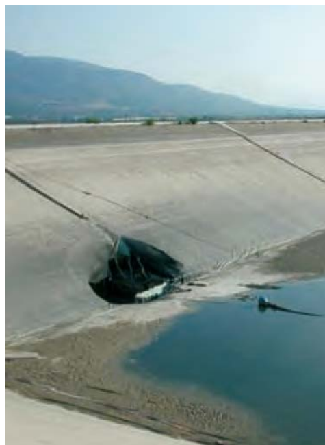
Tubificació des de talús interior
