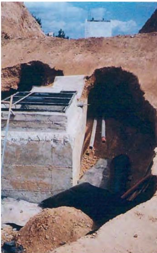
Tubificació des de l'arqueta d'escomesa.
